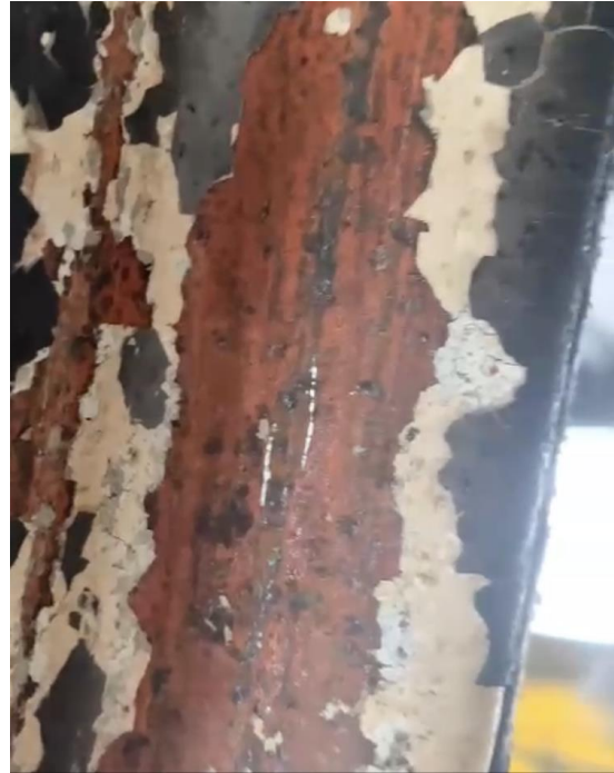
Foto Nr. 32 Zem diviem krāsas slāņiem redzama gruntskrāsa. Foto Nr. 33 Zem gruntskrāsas spīdīga metāla struktūra.
