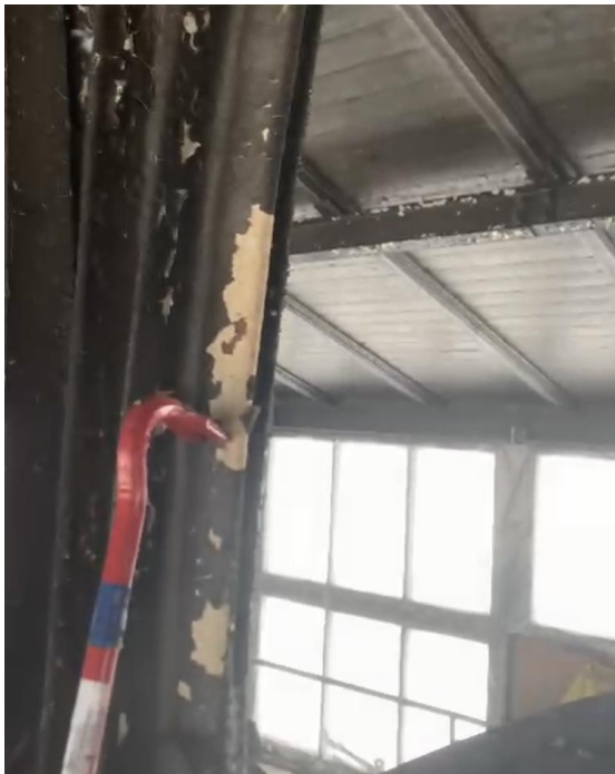
Foto Nr. 30 Mehāniski noņemts virsējais krāsas slānis.
