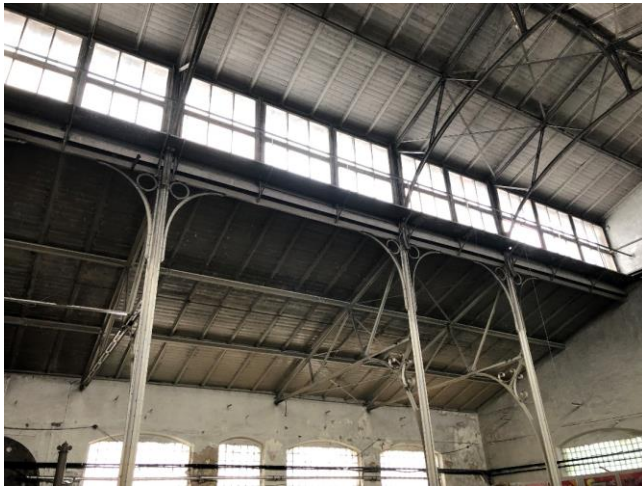
Foto Nr. 6 Jumta konstrukcija.
