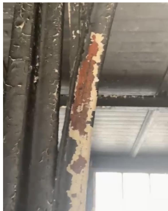
Foto Nr. 31 Mehāniski noņemts otrais krāsas slānis.
