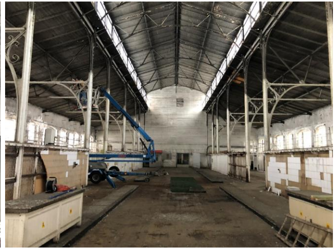
Foto Nr. 7 Jumta konstrukcija.
