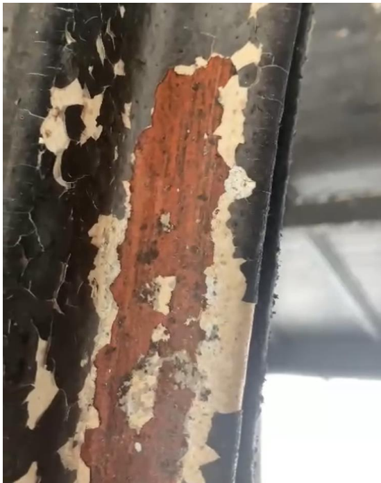
Foto Nr. 32 Zem diviem krāsas slāņiem redzama gruntskrāsa. Foto Nr. 33 Zem gruntskrāsas spīdīga metāla struktūra.
