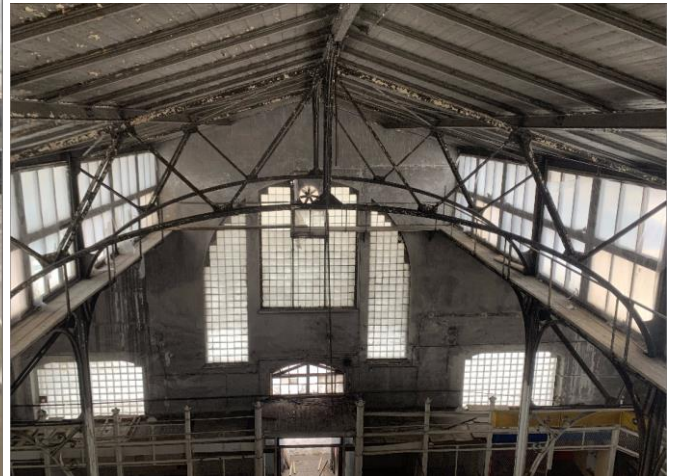
Foto Nr. 17 Virsgaismas daļas kopnes konstrukcija.
